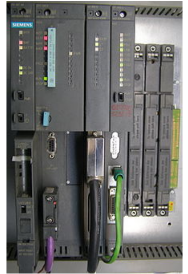
底板上由左至右分别是：电源模块PS407 4A，处理器模块416-3，接口模块IM 460-0和通讯处理器模块CP 443-1
