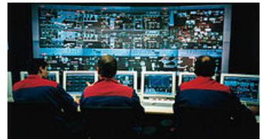
DCS系統控制室，工廠的資訊及控制命令都顯示在電腦繪圖螢幕上。操作員的座位可以讓他們透過畫面看工廠製程中的任一部份，並進行控制，同時仍可以看到整體的工廠製程。
