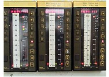
上面有簡單面板，整合顯示機能的控制器。過程變數（PV）及設定值（SV）設計成相同的刻度以方便比較。控制器輸出為MV（manipulated variable），範圍為0-100%。
