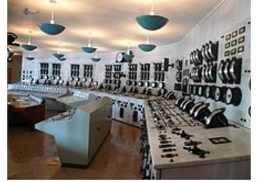
導入DCS之前的中央控制室。控制設備雖然都集中在同一個位置，不過仍然是各別獨立的系統，沒有整合成一個系統
